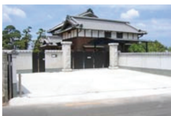
N邸 外構工事
