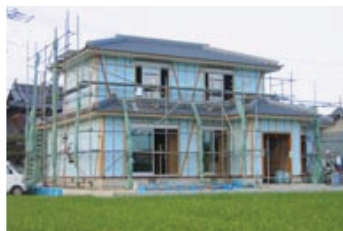
OT邸 外断熱工法
