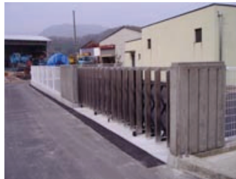
県立総合水泳プール外構施設 災害復旧その他工事
