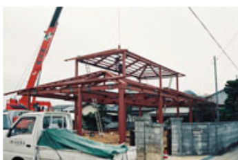
K邸 (施工中)
