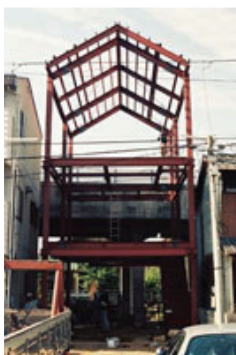
N邸 (施工中)
