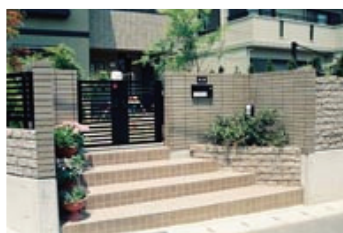
K邸 外構工事
