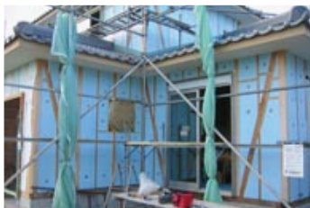
OT邸 外断熱工法
