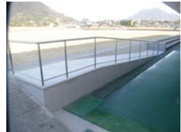
平成19年度 香川県総合運動公園 球技場管理棟改修工事
