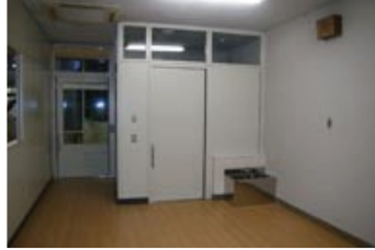
中野保育所大規模改修工事
